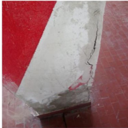
3.4 - lesione intonaco nel settore inferiore all'androne
