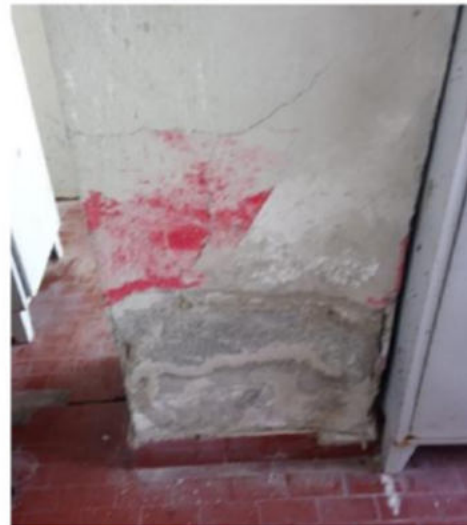
3.4 - lesione intonaco nel settore inferiore all'androne
